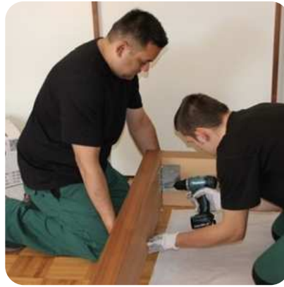
Abbau und Aufbau durch eigene Monteure
