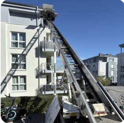
Der Aufzug wird am Balkon angesetzt
